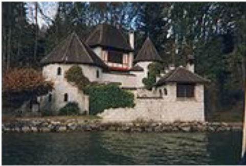
La tour de Bollingen, construite par C.G. Jung.
